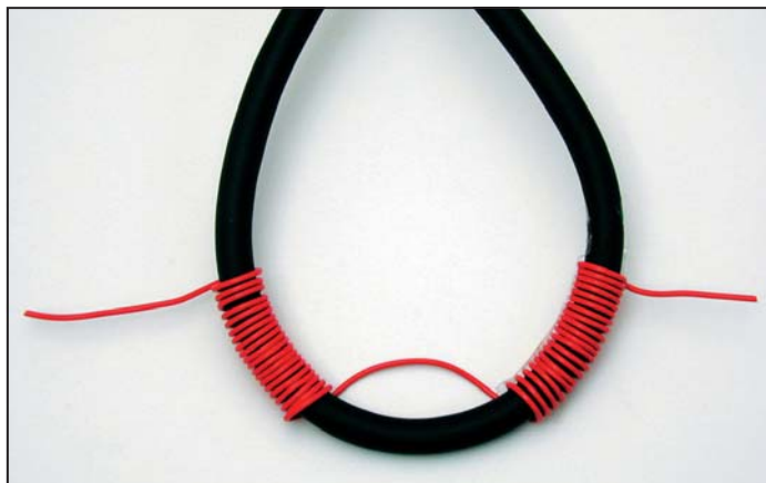
En la imagen pueden ver como deben montar las dos bobinas entorno del tubo del agua.
